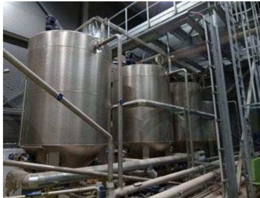
Die Hygienisierung bzw. Pasteurisierung mit drei Behältern ist von den verschiedenen Verfahrensvarianten meist am besten geeignet, um ggf. die gesamten Klärschlämme einer Kläranlage vor der Faulung zu behandeln. Neben der optimalen Wärmenutzung kommt hinzu, dass ähnliche Effekte wie bei dem Verfahren zur thermisch-chemischen Desintegration mit genutzt werden können und damit die Faulgasausbeute steigt..
